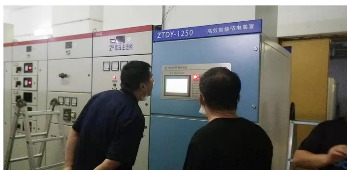
图 8 项目产品安装现场
