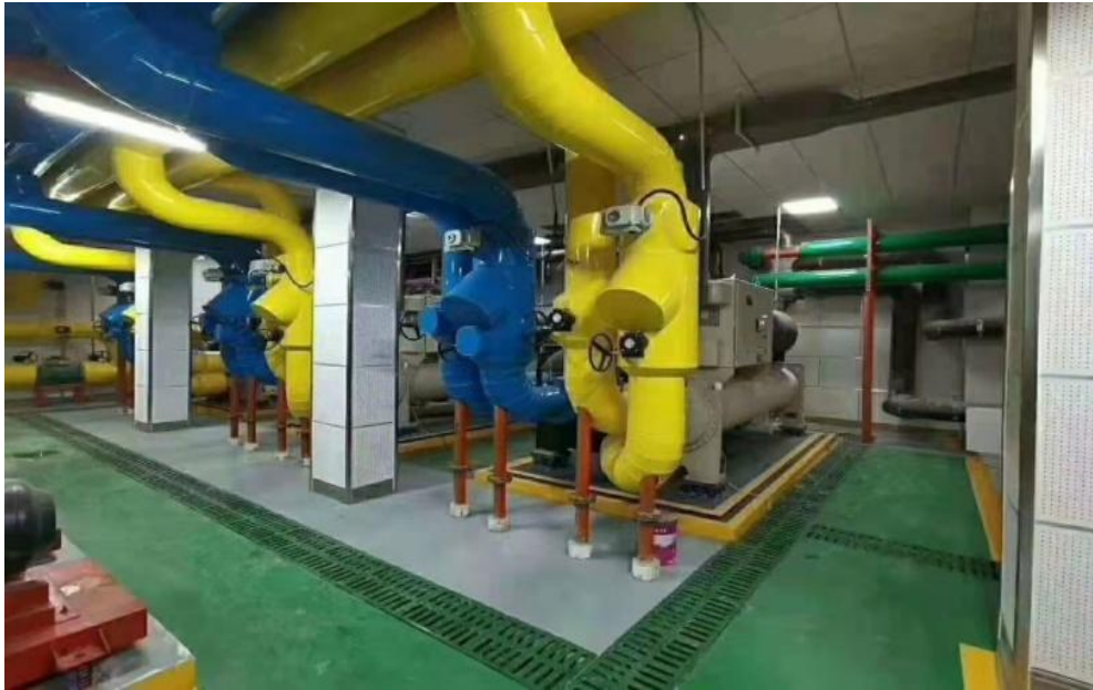
图 2 机房改造后现场图
