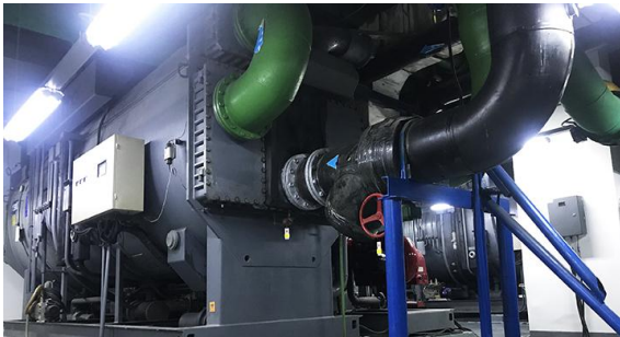
图 2 改造前机房现场图
