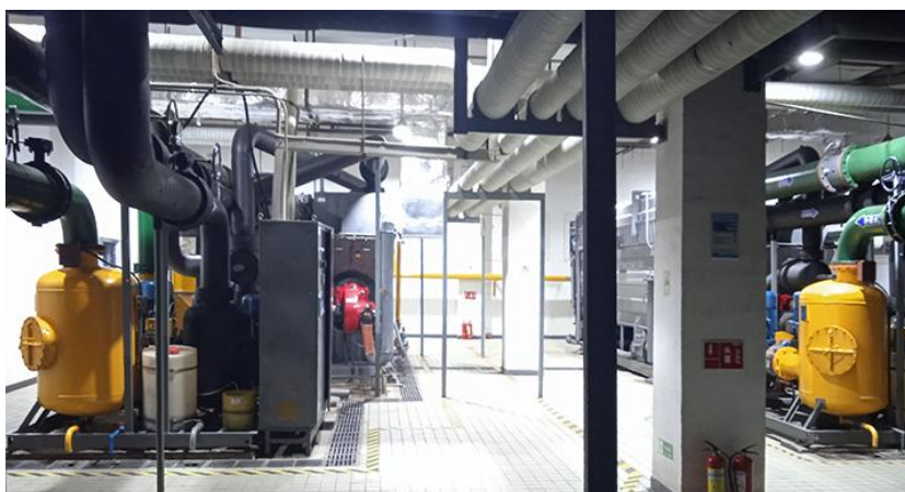
图 5 改造前机房现场图
