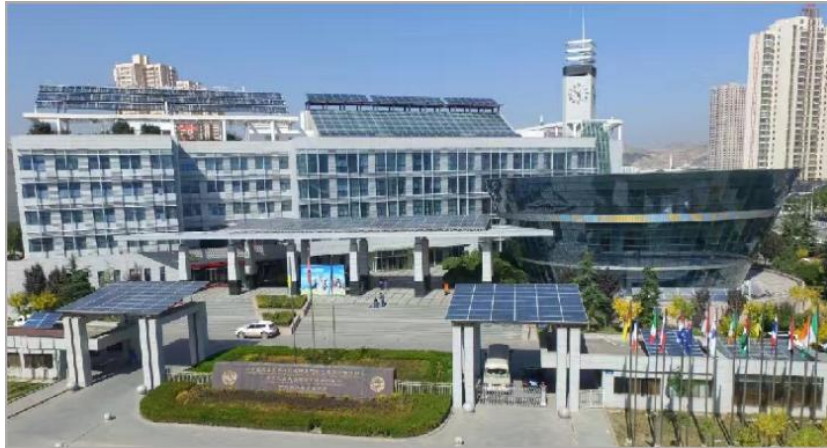
图1 国际太阳能中心
