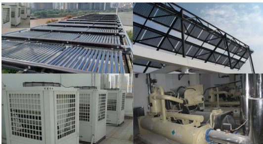
图2 太阳能及热泵供热利用
